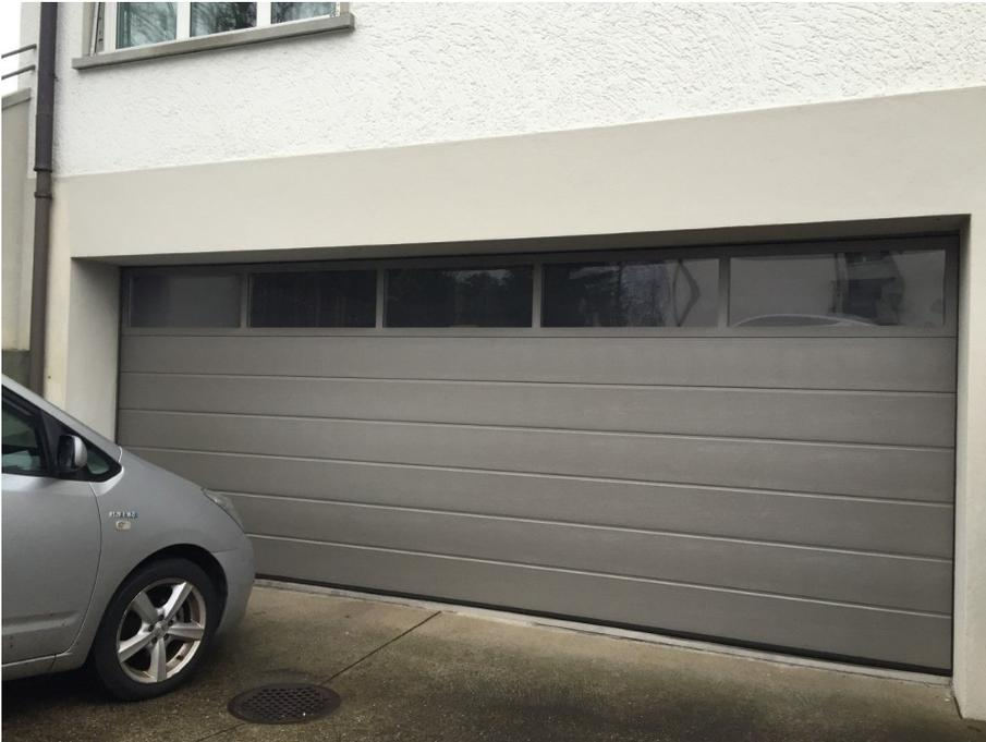
**Sectionaltor LPU40 M-Sicke woodgrain RAL 9007 graualuminium verglasungsrahmen**
