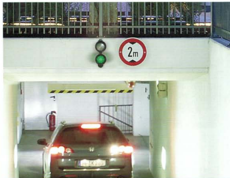
Fahrbahnregelung in Kombination mit Signalleuchten regeln sicher und zuverlässig die Ein- und Ausfahrt.
